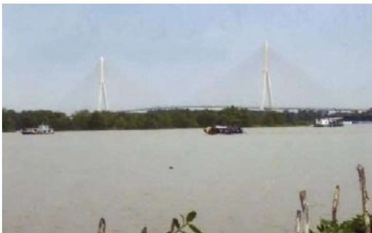
Abbildung 8: Vordergrund: Fischerbote, Hintergrund: Brückenbauwerk (Quelle: Anhang Nr.8)
