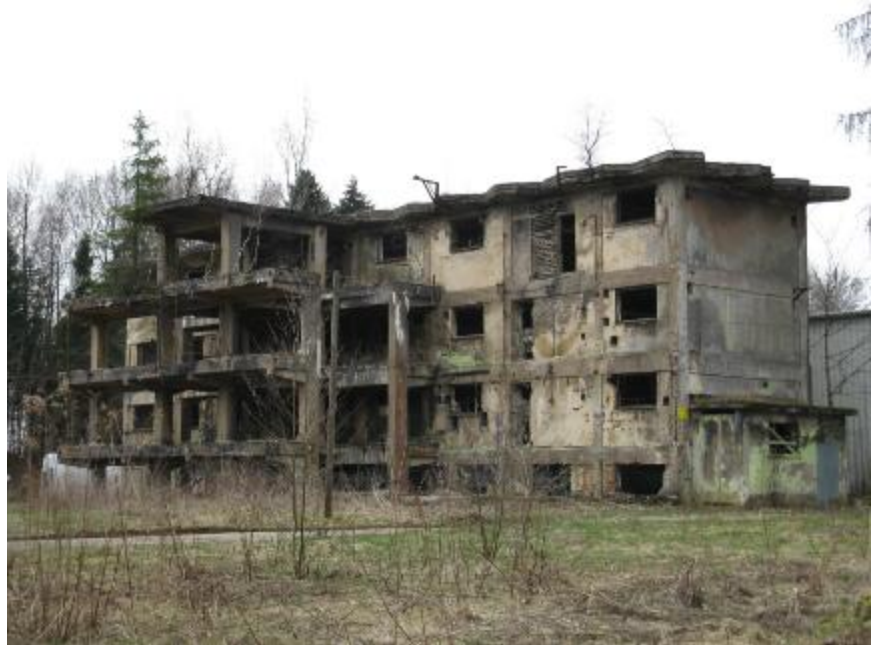
Abbildung 2: Betonrahmenbau in Hirschhagen
