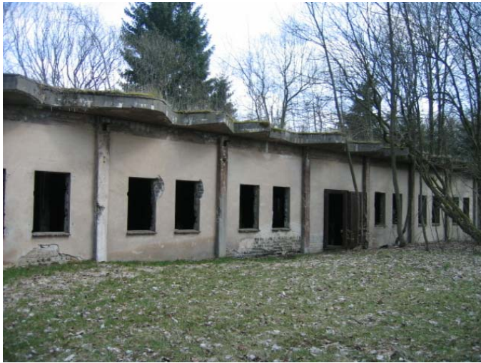
Gebäude Nr. 312: Abfall-Säurelager 7
