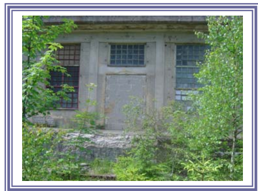
Ähnliche Konstruktion: Gebäude der Munitionsfabrik Hirschhagen
