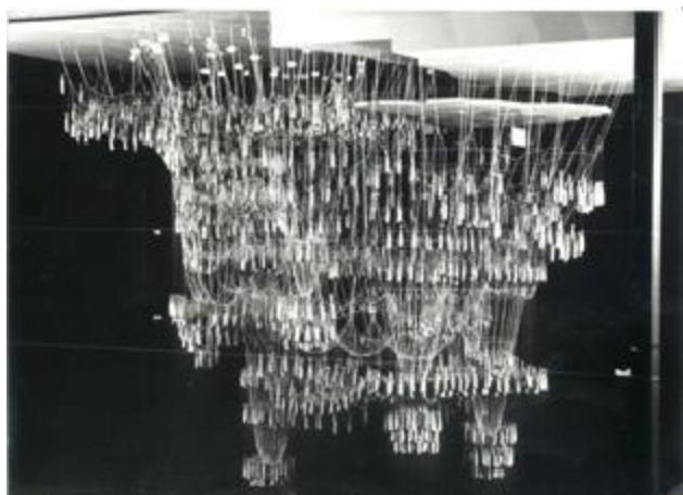
Abbildung 4: Rekonstruktion des Hängemodells von Rainer Graefe, Frei Otto, Jos Tomlow und Arnold Walz
