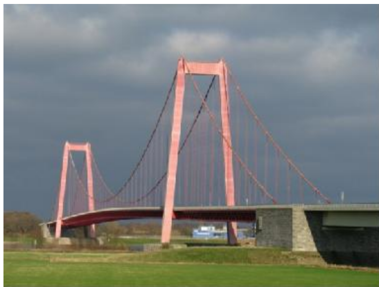
Abbildung 6: Die längste deutsche Hängebrücke, die Rheinbrücke Emmerich
